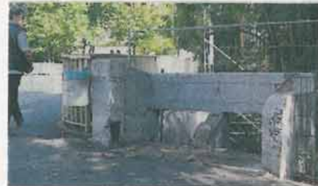
So sieht die Steinbank jetzt noch aus.
